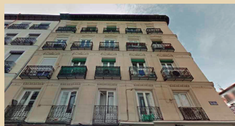
Fachada calle de Hartzzenbusch Orientación norte
